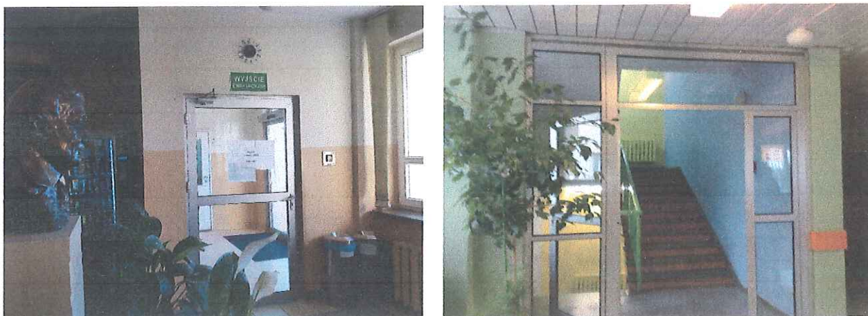
Widok hallu głównego wejściowego oraz klatki schodowej
